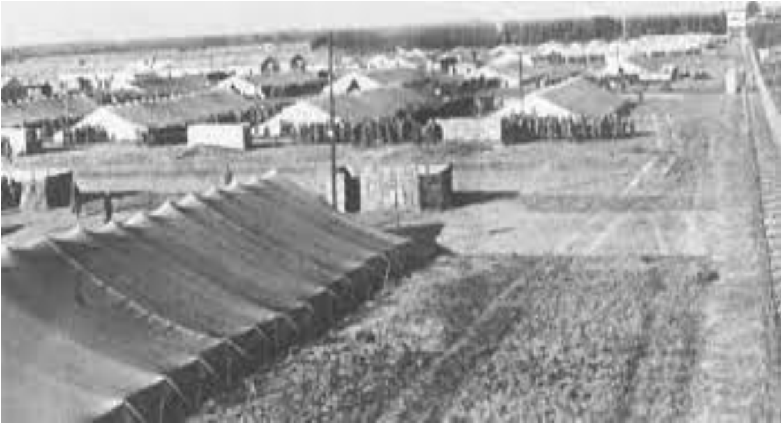
Stammlager III A Luckenwalde
